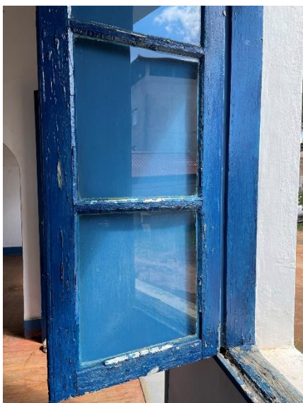
Figura 17: Esquadria da fachada frontal da Casa Sede. Apresenta rachaduras e perda de camada pictórica.
