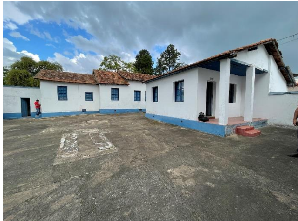
Figura 03: Lateral posterior direita da Casa Sede, onde o passeio se encontra com erosões e perda de superfície, características que se repetem ao longo das edificações do prédio.
