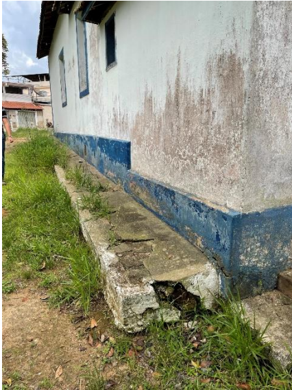
Figura 03: Lateral posterior direita da Casa Sede, onde o passeio se encontra com erosões e perda de superfície, características que se repetem ao longo das edificações do prédio.
