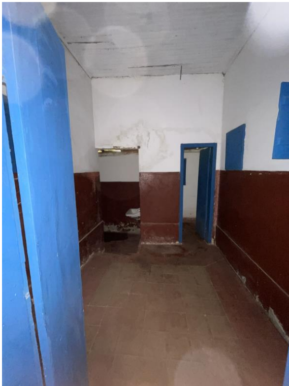
FOTO 26 : Ambiente 10 da Casa Sede. Lacunas, depósitos escuros e envergadura do forro. Paredes com desprendimento de camada pictórica e sujidades em todas as superfícies. Afundamento do piso com desbotamento de sua superfície.
