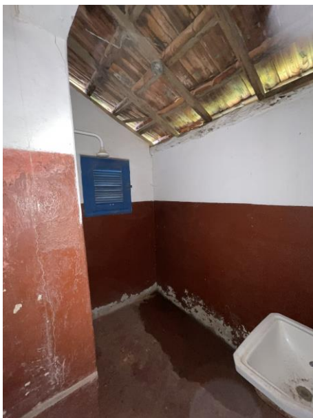
FOTO 26 : Ambiente 10 da Casa Sede. Lacunas, depósitos escuros e envergadura do forro. Paredes com desprendimento de camada pictórica e sujidades em todas as superfícies. Afundamento do piso com desbotamento de sua superfície.
