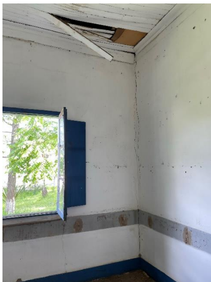
Figura 05: Parede interna de um dos ambientes da Casa Sede, com rachadura que se estende do piso ao teto na quina entre duas paredes.
