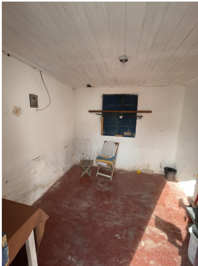
FOTO 37: Ambiente 19: anexo da Casa Sede. Sujidades e lacunas no forro. Desprendimento de camada pictórica, depósitos escuros e manchas de umidade nas paredes. Piso com desprendimento de camada pictórica e rachaduras.
