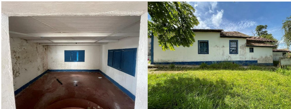
Figura 09: Vista frontal das paredes da coxia do Salão. Perda de camada pictórica e manchas de umidade são as características mais presentes.
