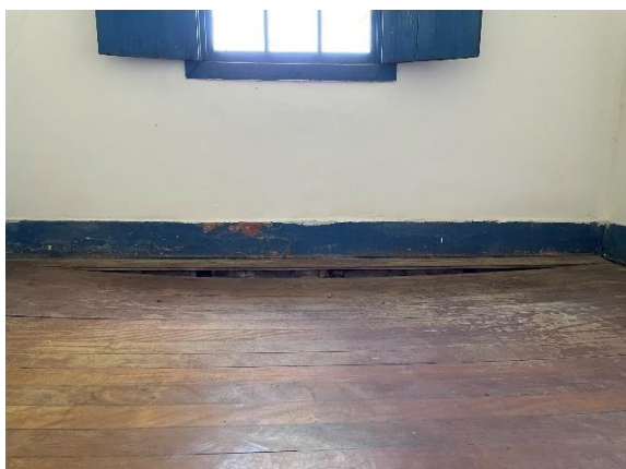
Figura 13: Ambiente interno da Casa Sede. Apresenta perda de superfície e envergadura de algumas tábuas, indicando lacunas na estrutura do piso.
