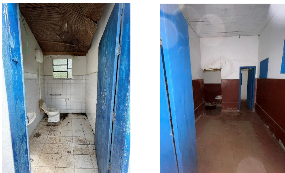
Figura 11: Vista frontal do banheiro externo à Casa Sede, com azulejos em bom estado de conservação.
