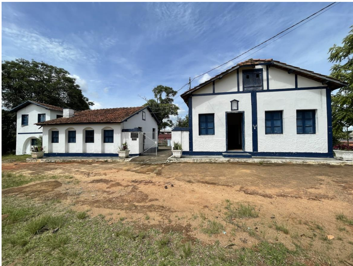
FOTO 01: Fachada frontal Casa Sede. Estado de conservação razoável, sendo a pintura aparentemente recente, apresentando algumas sujidades próximo às esquadrias, além de destelhamento na frente.
