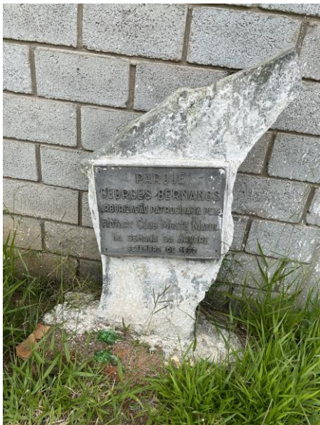
FOTO 04: Pedra da placa de arborização. Desprendimento da camada pictórica presente na pedra. Presença de detritos sólidos na base do elemento.
